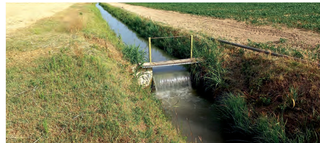
FOTO - Attività di regolazione delle paratoie di derivazione da parte del Consorzio di Bonifica
