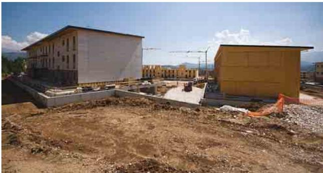
Foto 2 - Edificio a pareti portanti in fase di costruzione.
