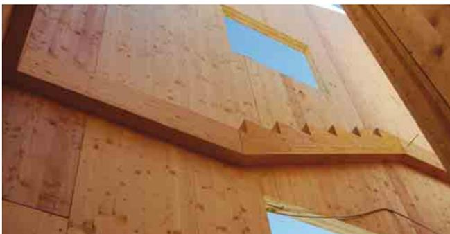
Foto 3 - Edificio a pareti portanti, particolare costruttivo.
