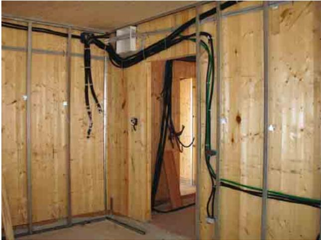
Foto 6 - Installazione dell'impianto elettrico su pareti di tipo "compensato di tavole".
