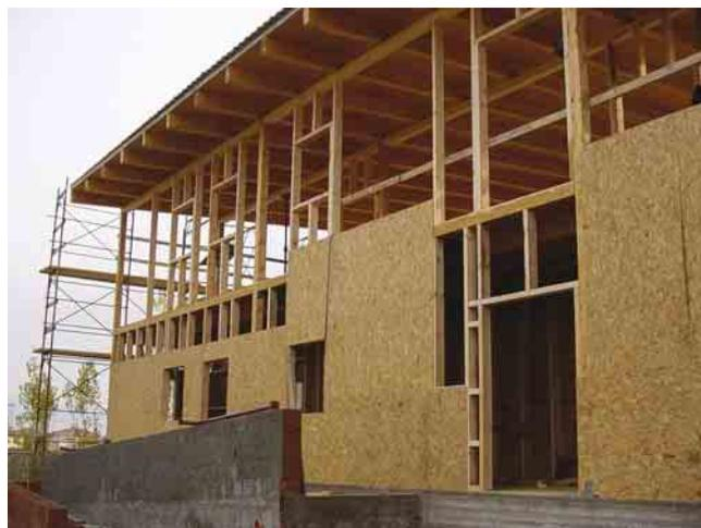
FOTO 1 - Edificio a pareti portanti di tipo "telaio e pannelli" in corso di realizzazione.
