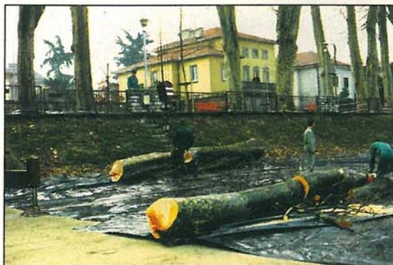
Figura 3 - Il depezzamento dei tronchi viene effettuato a terra su teli di plastica. (Foto E. GERVASINI)
