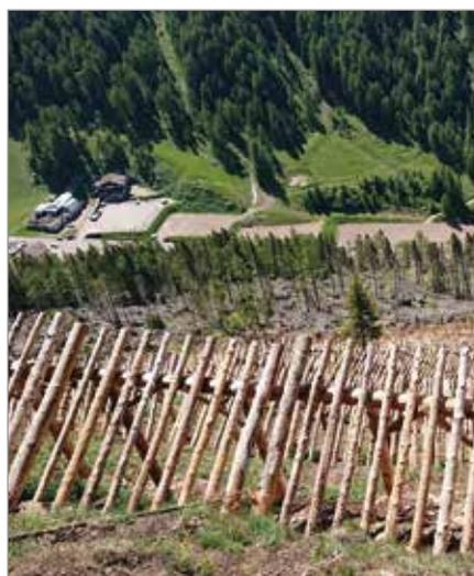
**Foto 8** - Paravalanghe eseguiti sul versante schiantato, tra un paravalanghe e l'altro sono stati realizzati gli impianti (foto: Servizio Prevenzione Rischi - P.A.T.).
