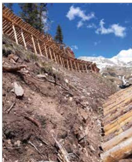
**Foto 9** - Paravalanghe eseguiti sul versante schiantato, tra un paravalanghe e l'altro sono stati realizzati gli impianti (foto: ANDREA CARBONARI - APROFOD).
